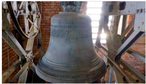
St. Petris älteste Glocke wurde 1878 zur Fertigstellung des Turmhelms eingeweiht
